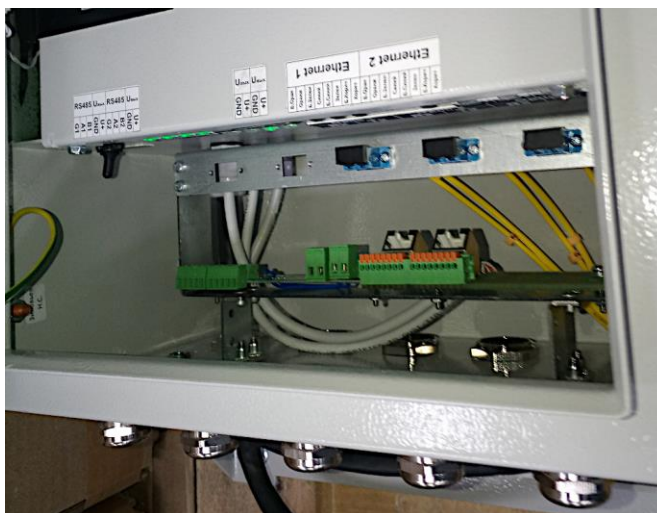
Рис. 2 Расположение клемм для подключения кабелей RS485, Ethernet и выхода питания
